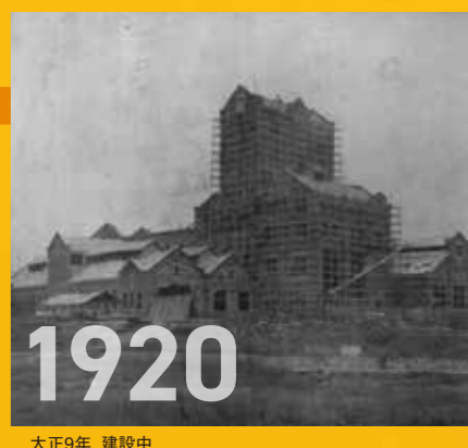
1920 大正9年 建設中
