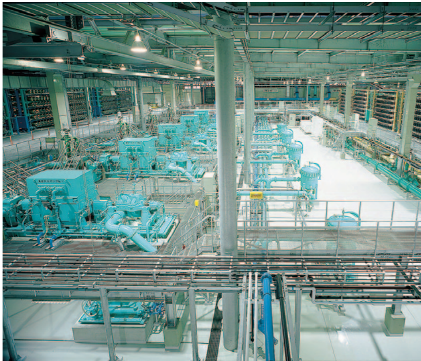
福岡市東区の奈多にある海水淡水化センター『まみずピア』には、全国各地からだけでなく海外からも見学者が訪れているそうです。
