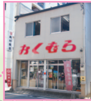
奥村商店 表は人形・玩具の卸屋、裏は駄菓子の間屋と、2つの顔を持つ中呉服町の隠れスポット。〈中呉服町2-24〉
